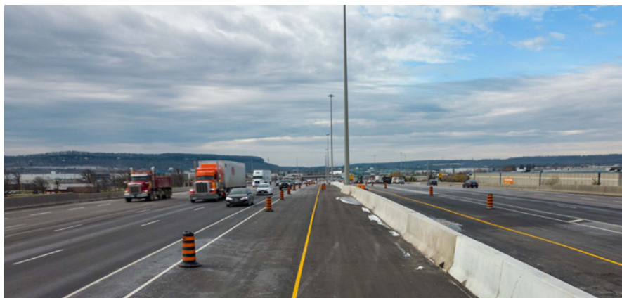
Les voies réservées aux VMO sont presque terminées.
