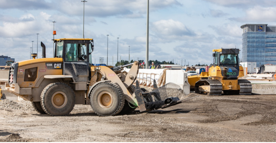
Des machines de WCC préparent des matériaux granulaires au pont ferroviaire du CP.
